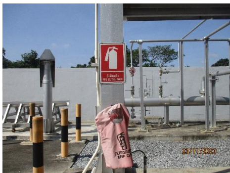
ภาพที่ 2-2 ถังดับเพลิงแบบเคมีผงที่สถานีควบคุมความดันและวัดปริมาณก๊าซธรรมชาติ (MRS)
